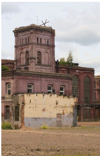
Budynki fabryczne przez wiele lat niszczały
